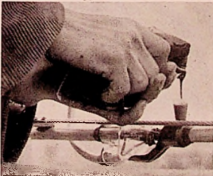
Het vullen van een "SCOTCHCAST" kabelas bij de aanleg van de verlichting van de IJsselbrug bij Velp.
